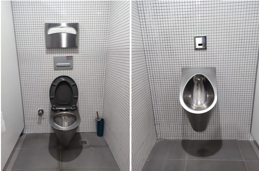
Resim 4: Çift faz rezervuar sistemi ve sensörlü pisuarlar
